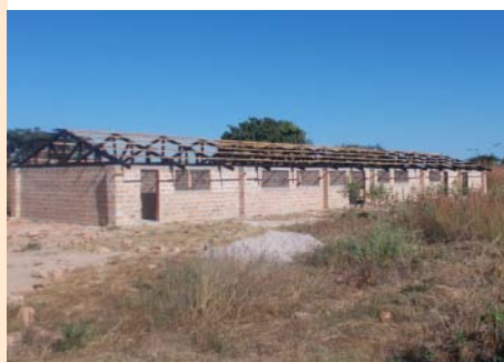
Kippen boerderij in aanbouw
