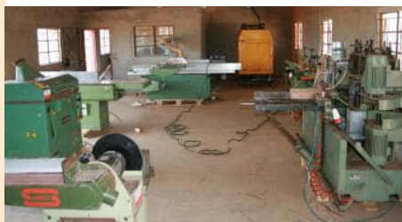
Houtbewerking machines geïnstalleerd
