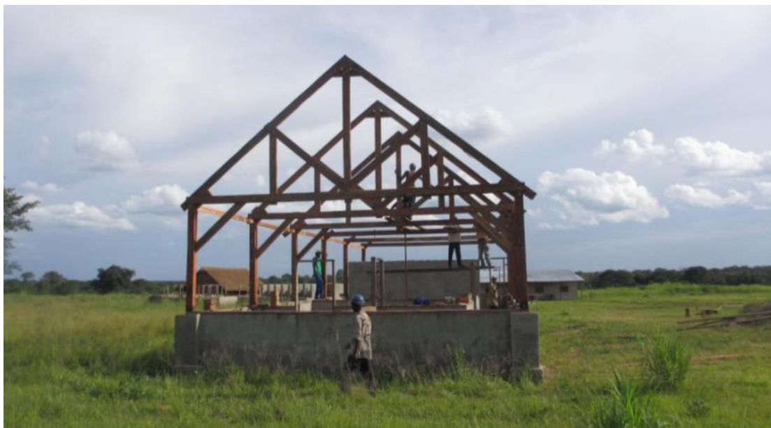
Het VTC in aanbouw
