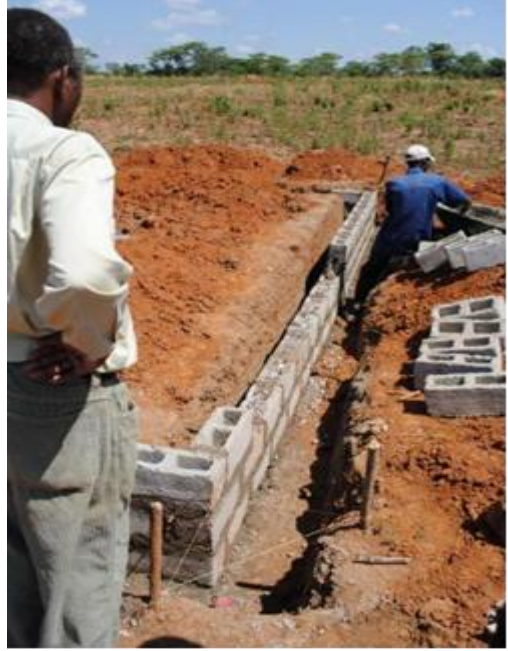
Fundering klaslokalen in aanbouw
