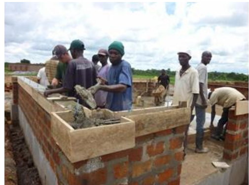
gebouw in aanbouw
