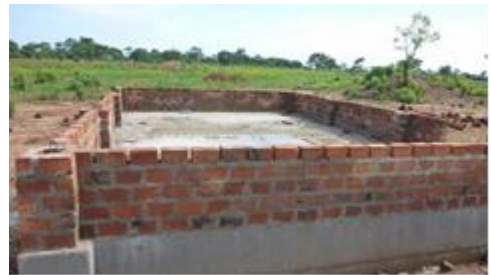
gebouw in aanbouw
