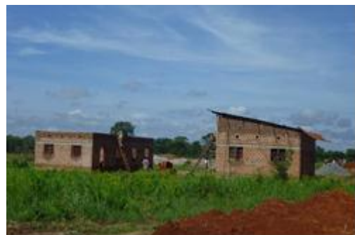
Gebouwen op het binnenterrein
